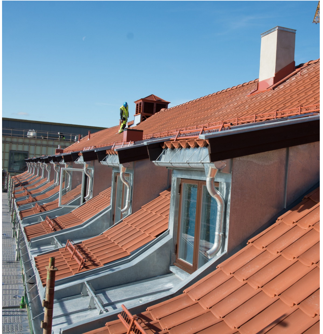
Ullerntunet bo- og behandlingssenter – BREEAM-NOR prosjekt
