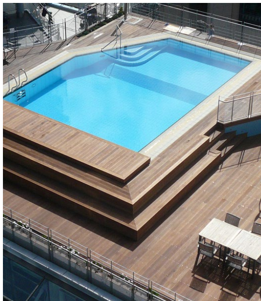
Bassengrehabilitering– Sameiet Aker Brygge
