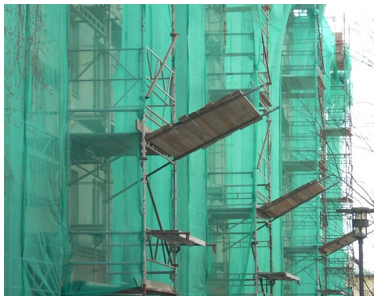
Vindusutskifting – Ålesundgata borettslag
